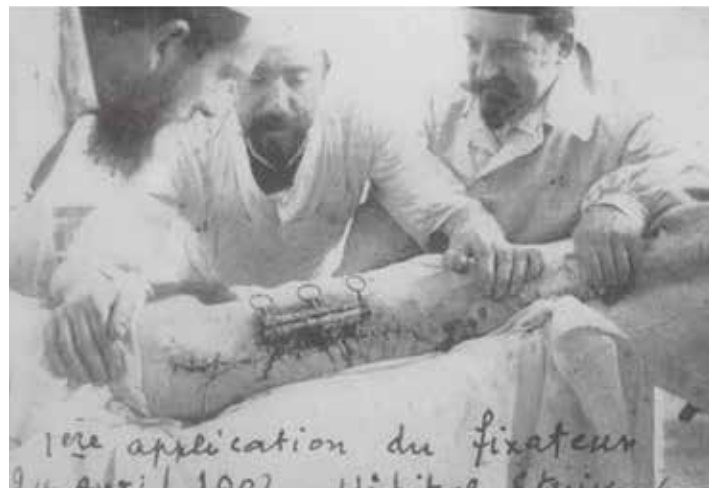
In 1902 gebruikte Lambotte voor de eerste keer een door hemzelf ontwikkelde externe fixateur.
